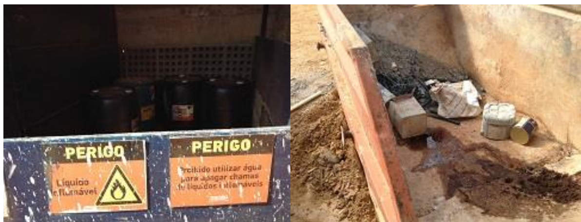
Figura 19 - Triagem de resíduos de Classe D nos canteiros de obras.
