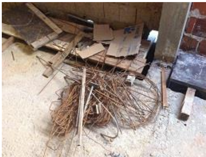
Figura 15 - Segregação de resíduos do aço em canteiro de obra.
