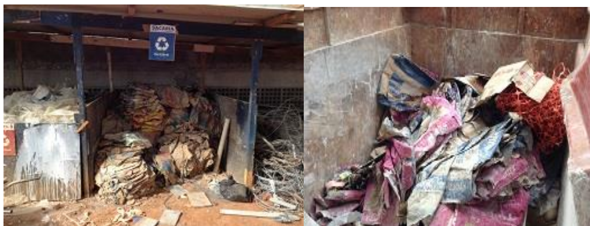
Figura 18 - Segregação de sacaria em canteiros de obras visitados.
