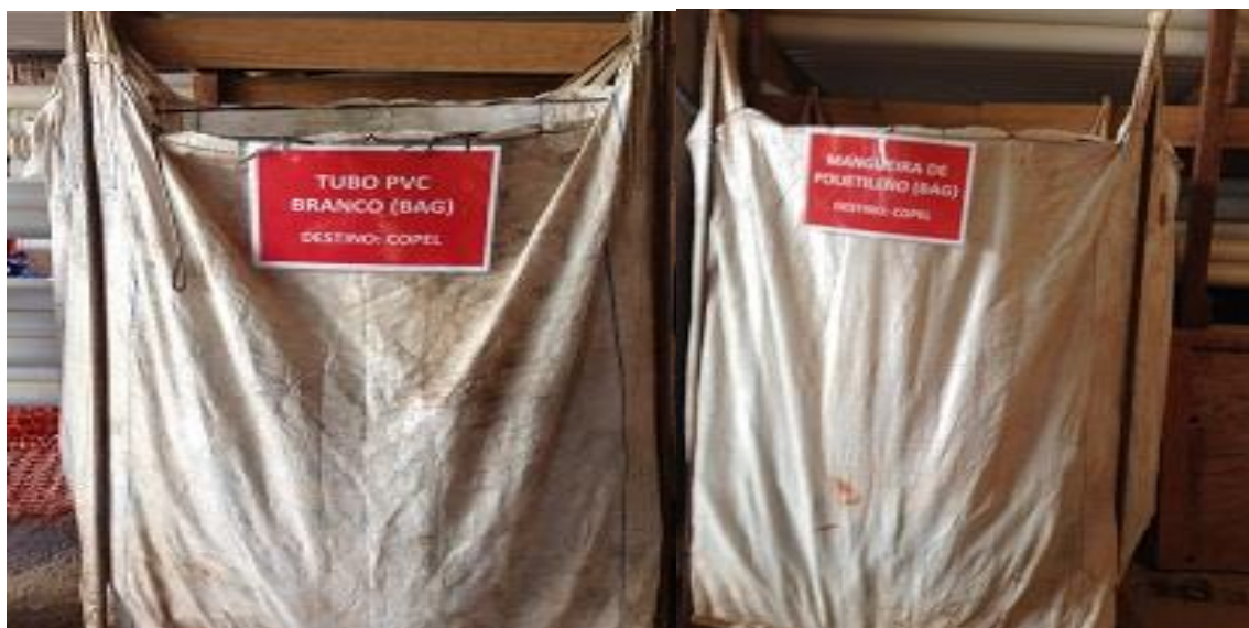
Figura 17 - Segregação de resíduos de plástico nos canteiros de obras visitados.
