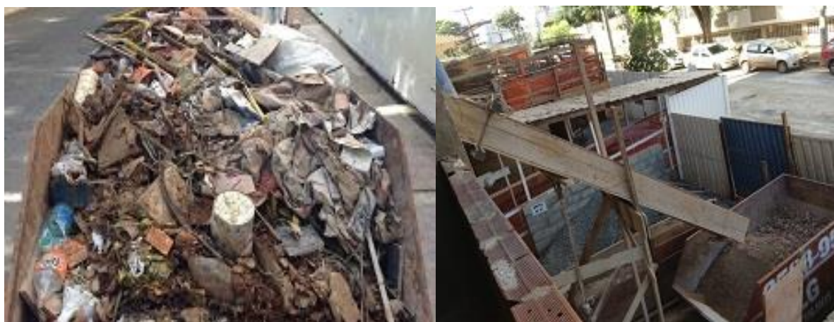
Figura 20 - Segregação de resíduos de classe A em canteiros de obras visitados.
