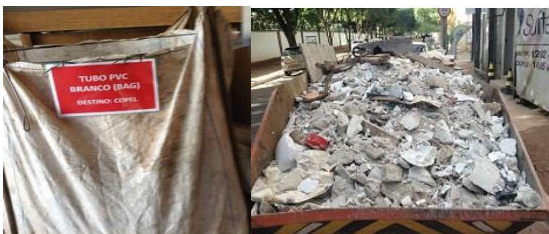
Figura 11 - Entulhos de construtoras com e sem gestão de resíduos.
