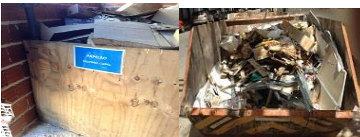
Figura 16 - Segregação de resíduos de papelão em canteiros de obras.
